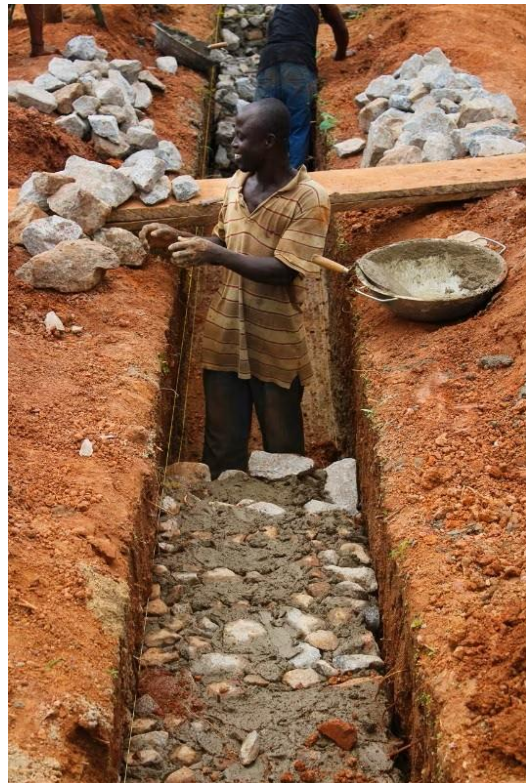
Figura 4.41: Fondazioni in pietra. Prototipo di scuola in Ghana, progetto di Andrea Tabocchini e Francesca Vittorini, Yeboahkrom, Ghana, 2017 (fonte: domus, https://www.domusweb.it/it/architettura/2018/02/21/Ghauna-scuola-costruita-a-mano-con-soli-12.000-euro.html , ultima consultazione 18/08/2023).
