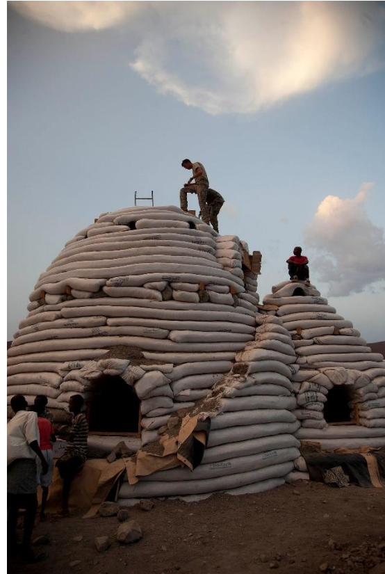
Figura 4.37: Tecnica del Superadobe (fonte: un passaggio per biotopia, https://www.unpassaggioperbiotopia.org/materiali/principali-tecniche-di-posa-con-la-terra/adobe/ , ultima consultazione 18/08/2023).
