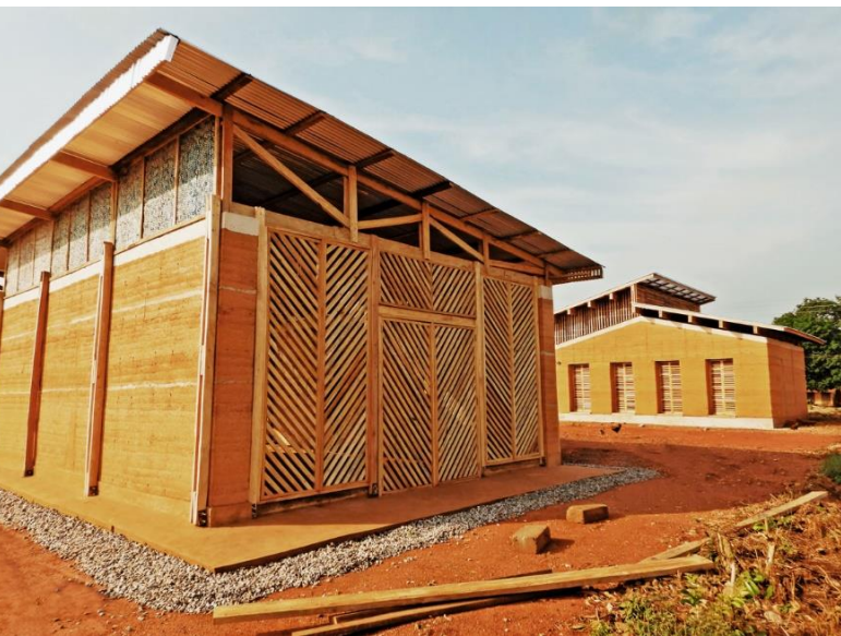
Figura 4.42: Elementi lignei utilizzati in varie modalità: serramenti, struttura portante. Aula per la junior high school del villaggio di Okorase, progetto di Irene Librando e Nadia Peruggi, Okorase, Ghana, 2018 (fonte: ARKT, < https://arkt.space/volontariato-ed-architettura-workshop-di-architettura-in-terra-cruda-in-ghana/ >, ultima consultazione 11/09/2023).
