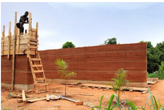
Figura 4.34: Tecnica del Pisè, Prototipo di scuola in Ghana, progetto di Andrea Tabocchini e Francesca Vittorini, Yeboahkrom, Ghana, 2017 (fonte: domus, https://www.domusweb.it/it/architettura/2018/02/21/Ghauna-scuola-costruita-a-mano-con-soli-12.000-euro.html , ultima consultazione 18/08/2023).
