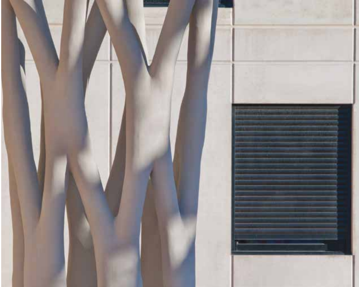
Fig. 047 Bâtiment équipements sportifs Marc Dalibard & XtreeE Métropole d'Aix Marseille, 2019
