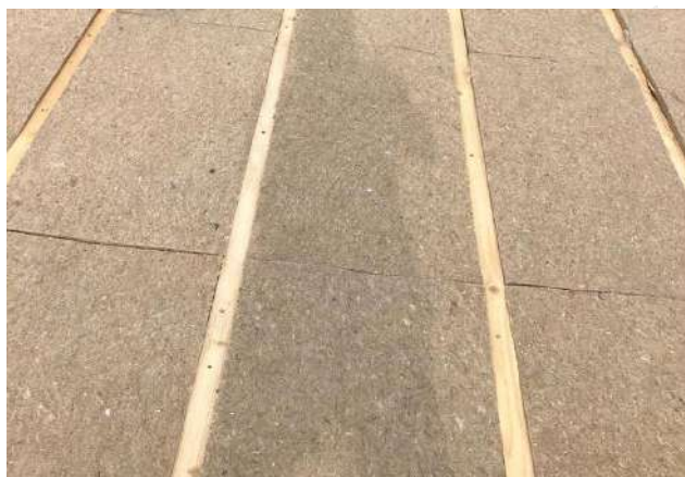
FOTO B: Applicazione isolamento tetto
