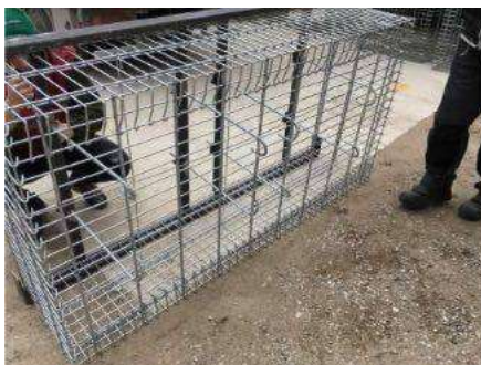
Figure 2.15 e 2.16 – Installazione tirafondi e riempimento gabbione
