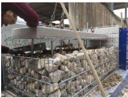
Figure 2.17 e 2.18 – Installazione pannello di copertura e movimentazione gabbione
