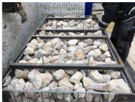
Figure 2.15 e 2.16 – Installazione tirafondi e riempimento gabbione
