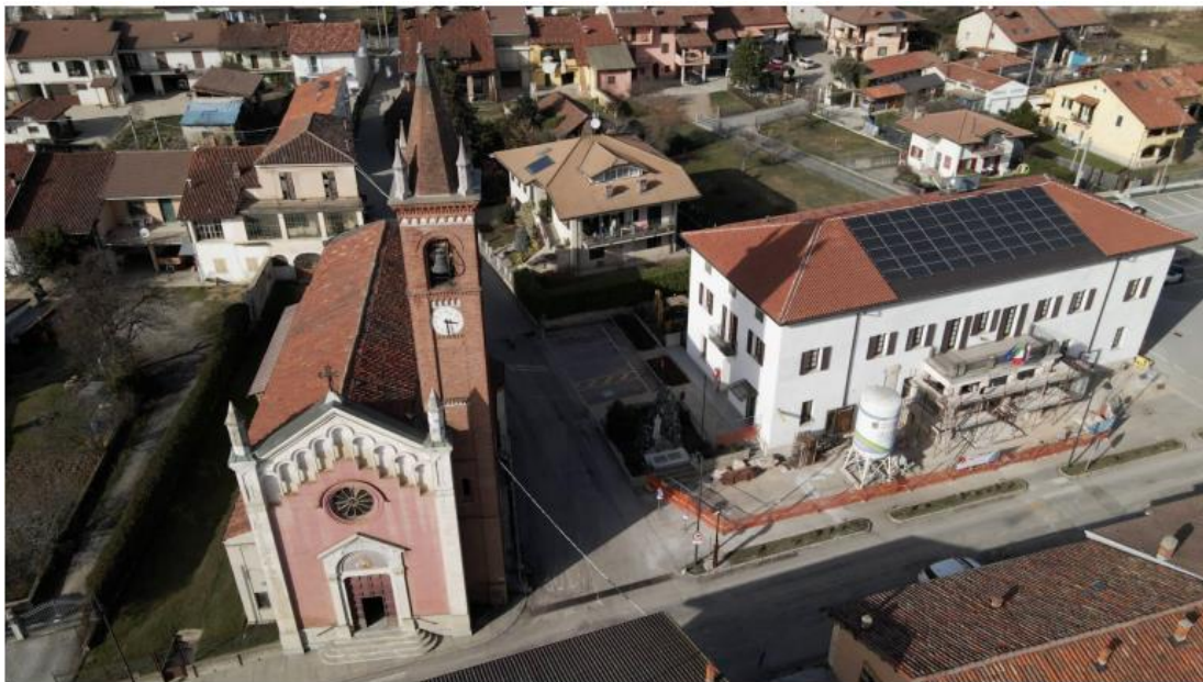
Figura 2.4 - Impianto FV installato sul municipio di Magliano Alpi (CN)
