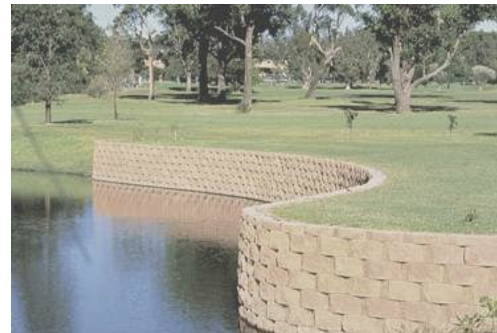
→ Muro di sostegno realizzato col sistema Keystone
