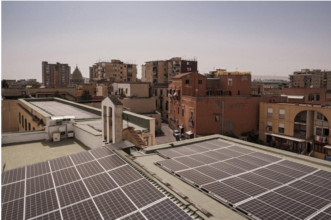
Figura 4.1: San Giovanni a Teduccio (Napoli Est). Pannelli fotovoltaici installati sui tetti della Fondazione Famiglia di Maria. (Fonte: Michele Amoruso per Internazionale https://www.internazionale.it/notizie/marina-forti/2021/07/12/san-giovanni-teduccio-comunita-energetica )
