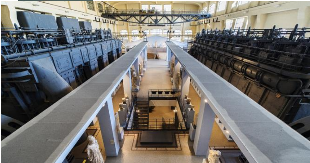
Tav. XXVII. Sala Macchine, dettaglio dell'allestimento visto dall'alto © Benedetta Avagliano
