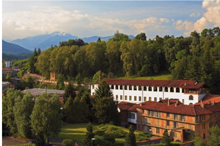
Tav. IV. Cittadellarte - Fondazione Pistoletto, Biella https://www.atl.biella.it/vedere-dettaglio/-/d/cittadellarte-fondazione-pistoletto
